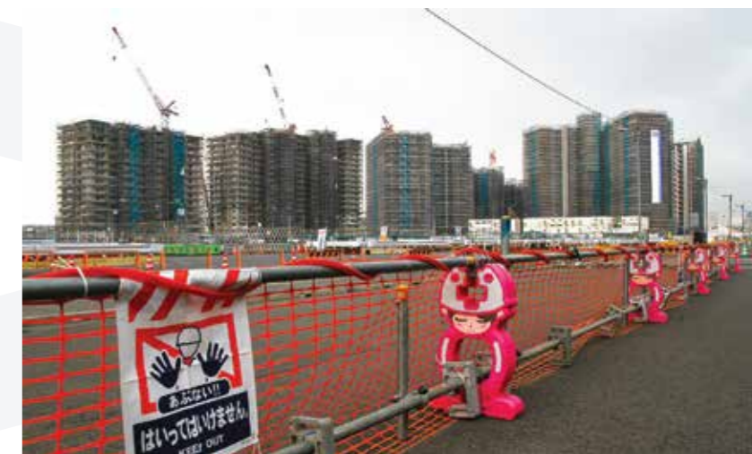
Siguen las construcciones en la Villa Olímpica. Serán 23 edificios con más de 5 mil departamentos que luego de los Juegos se ofrecerán en venta.
